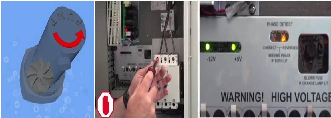
شكل رقم ٢٠: فحص الفازة (طور) ظلمبة التبريد
