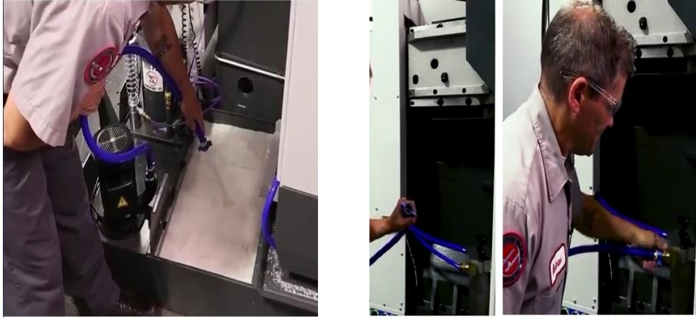
شكل رقم ٢٤: فحص وصلات (خراطيم) طلمبة التبريد
